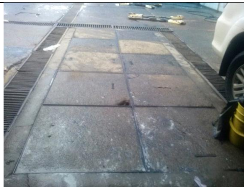
Foto No. 2. Sistema de trampa de grasas
